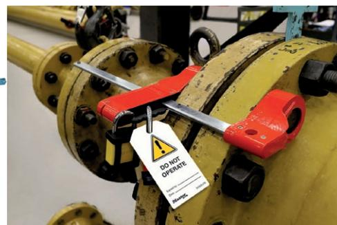
Todos os dispositivos de bloqueio mecânico podem ser usados com os cadeados e etiquetas Master Lock
